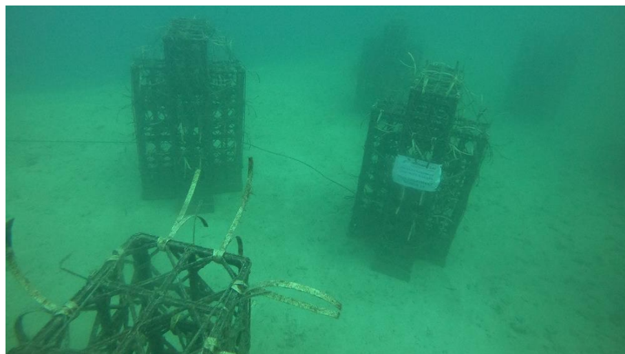
Gambar 5.1 Gambaran umum kondisi rumah ikan ( fish apartment ) pada April 2021; semua modul masih berdiri kokoh dan dalam kondisi yang baik (Dokumentasi kegiatan, 2021)
