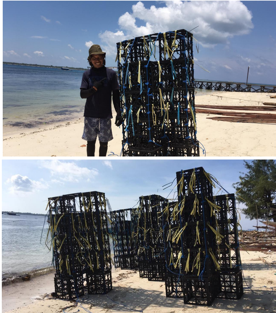
Gambar 2.7 Unit-unit sub-modul yang telah dirangkai menjadi modul rumah ikan dan telah dilengkapi dengan tali atraktor serta siap untuk diangkut menuju ke lokasi peletakan (penenggelaman) (PT Pertamina Gas OEJA, 2020c)
